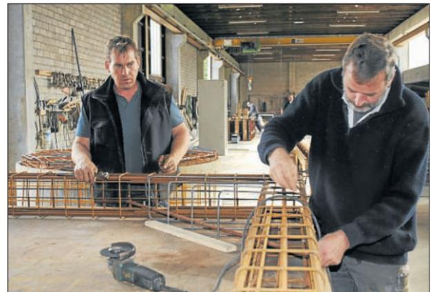
Witt-Mitarbeiter arbeiten an einer Bewehrung. Damit wird das Stahlgeflecht bezeichnet, an dem der Beton sich „festhält“.
