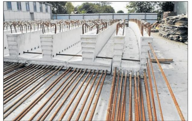
Fertigteile für eine Betonbrücke, die zwischen Tönning und Husum eingebaut werden soll.
