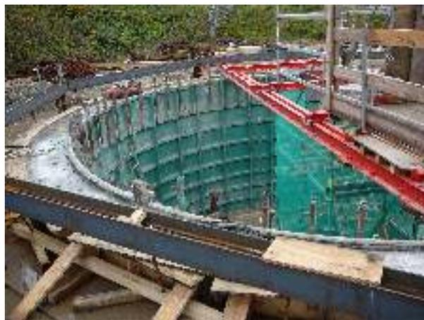
Schachtbauwerk für den Zugang zum Düker
