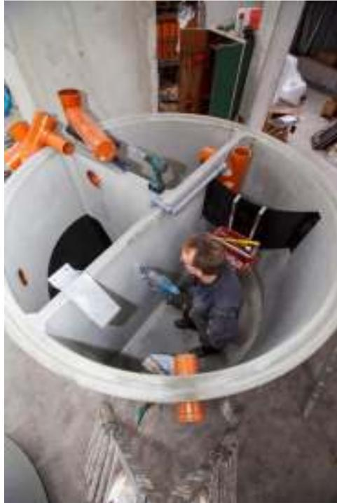
Montage der Kläranlagentechnik in einem Monolith-Behälter 2016
